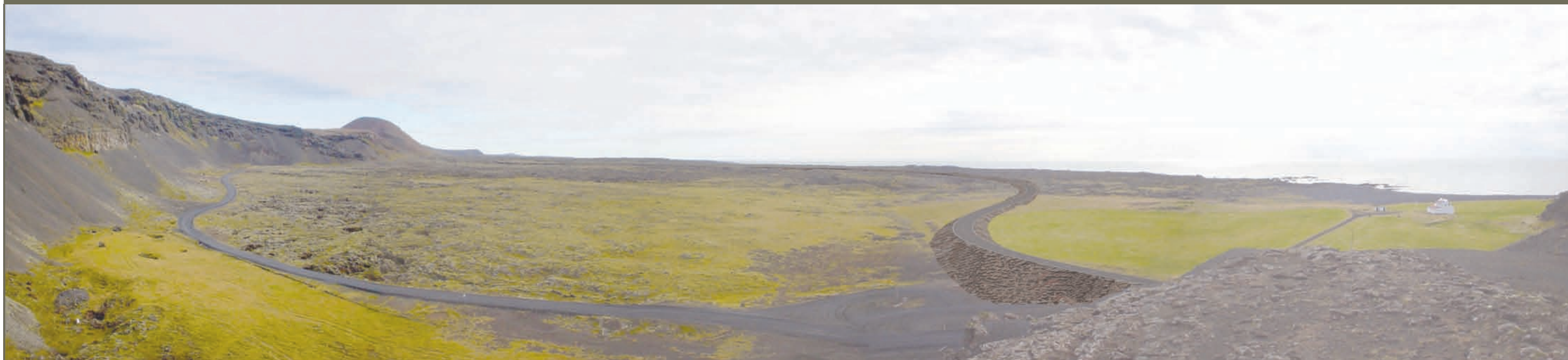
Áætluð ásýnd Suðurstrandarveggar við Ísólfskála - Stöð 8300 á rauðu veglínunni. Gamli vegurinn sýnilegur
